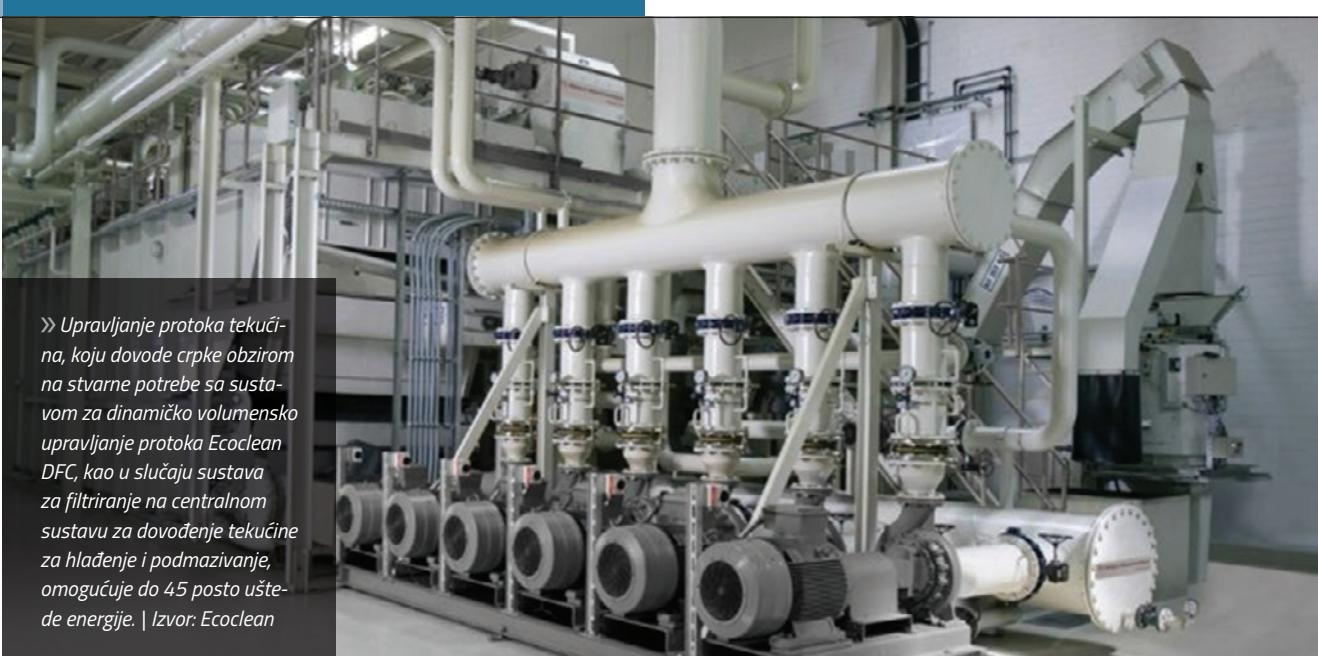
» Upravljanje protoka tekućina, koju dovode crpke obzirom na stvarne potrebe sa sustavom za dinamičko volumensko upravljanje protoka Ecoclean DFC, kao u slučaju sustava za filtriranje na centralnom sustavu za dovođenje tekućine za hlađenje i podmazivanje, omogućuje do 45 posto uštede energije. | Izvor: Ecoclean
